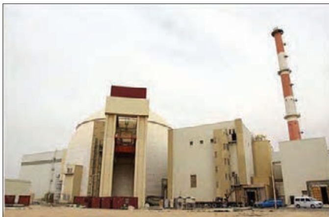
نیروگاه اتمی بوشهر
