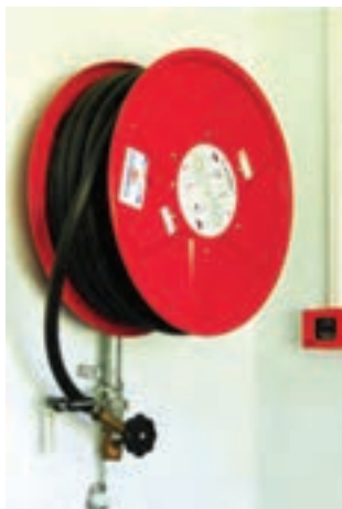
شکل ۴-۲- یک نمونه شیلنگ قرقره آب تحت فشار
